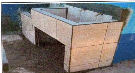
FOTO 4: Sustrucción de Azulejo para pila en Baños
