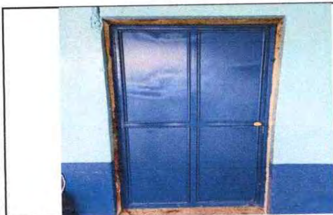
FOTO 5: Mantenimiento a estructura (lijado, cambio de tubo , cepillado, sujeciones, aplicación de pintura) ( 2 x1 mts) PUERTA DE COCINA
