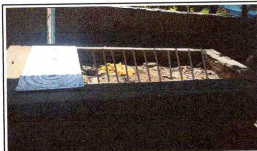
FOTO 9: Sustrucción de estufa rural (completa) incluye chimenea y plancha de metal EN COCINA
