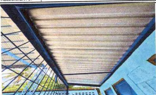
FOTO 1: Sustrucción de lámina, por lámina troquelada aluzinc calibre 26 EN BAÑOS
