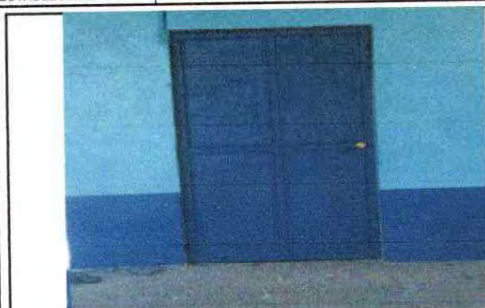
FOTO 13: Sustrucción de puerta 2X1 Metro EN AULAS
