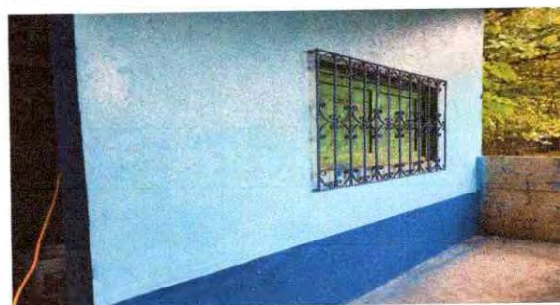
FOTO 6: Mantenimiento a balcones de metal EN COCINA
