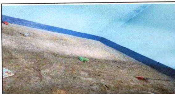
FOTO 15: Reparación de piso de cemento liquido EN AULAS
