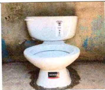
FOTO 3: Sustrucción inodoro en baños
