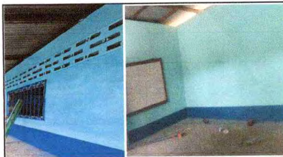
FOTO 16: Pintura en muros exteriores e interiores AULAS
