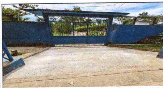
FOTO 17: Sustrucción de piso de torta de concreto EN PATIO
